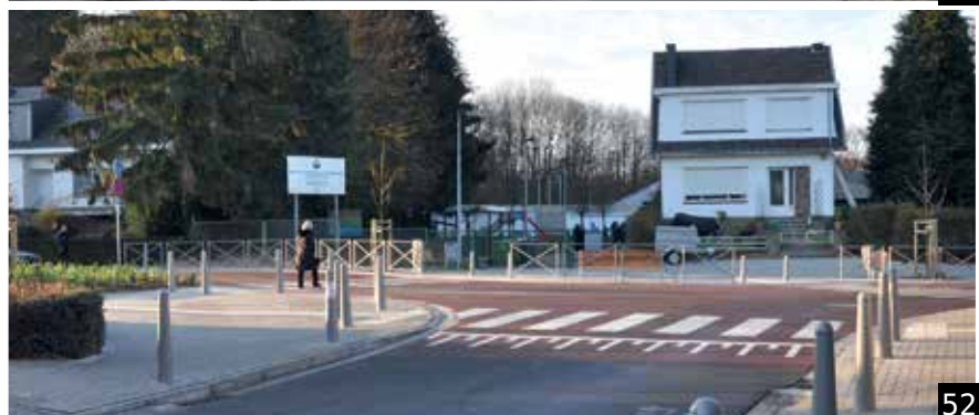
Figure 51 : Vue prise de la rue de l'Aunaie avant l'aménagement.
